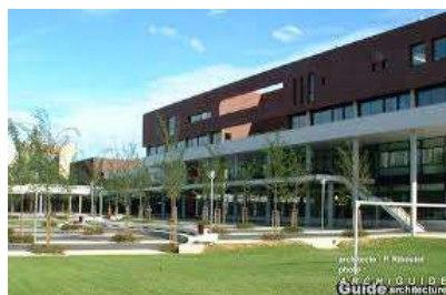
Lycée Le Corbusier d'Aubervilliers
